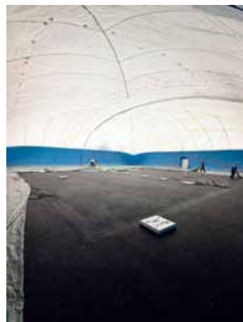
Erste Einblicke in die Traglufthalle und die darin entstehenden Padelplätze.
